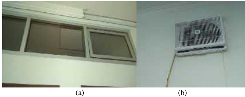
Gambar 6. (a) Ventilasi buatan, dan (b) Blower di pasang di ruang tanpa ventilasi
